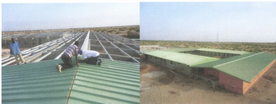
Sopra e nelle foto precedenti: fasi di edificazione della scuola materna e dell'orfanotrofio all'interno del "Villaggio Don Mario Pasini"
