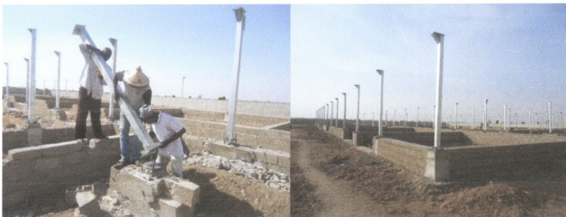
Posa dei pilastri della Scuola materna del "Villaggio Don Mario Pasini", in Mali
